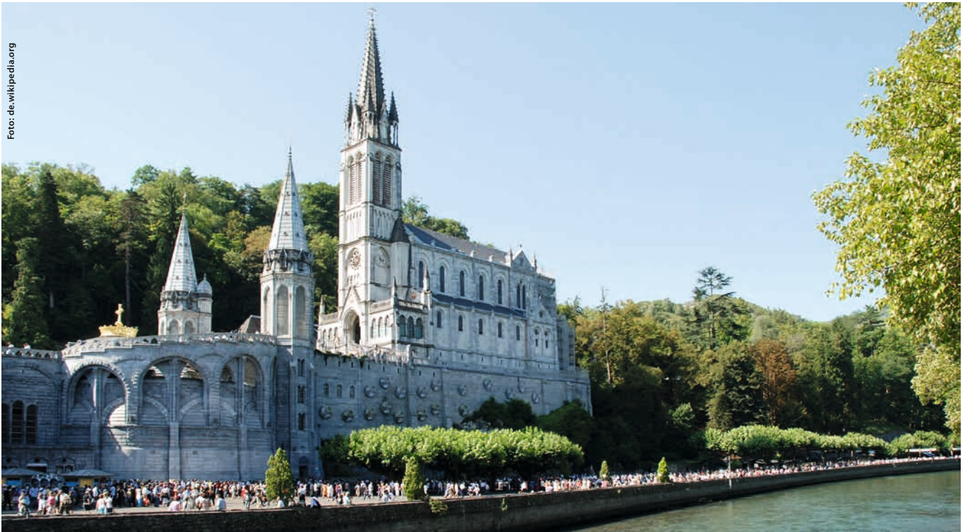
Die Wallfahrtskirche in Lourdes
