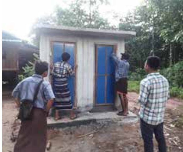
Costruzione di servizi sanitari con l'aiuto dei abitanti
